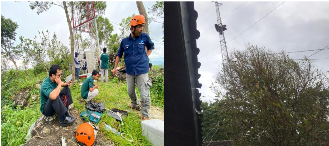
Gambar 3.64 Perbaikan Jaringan (Tower) dan Pemasangan Kamera Pemantau (CCTV)
