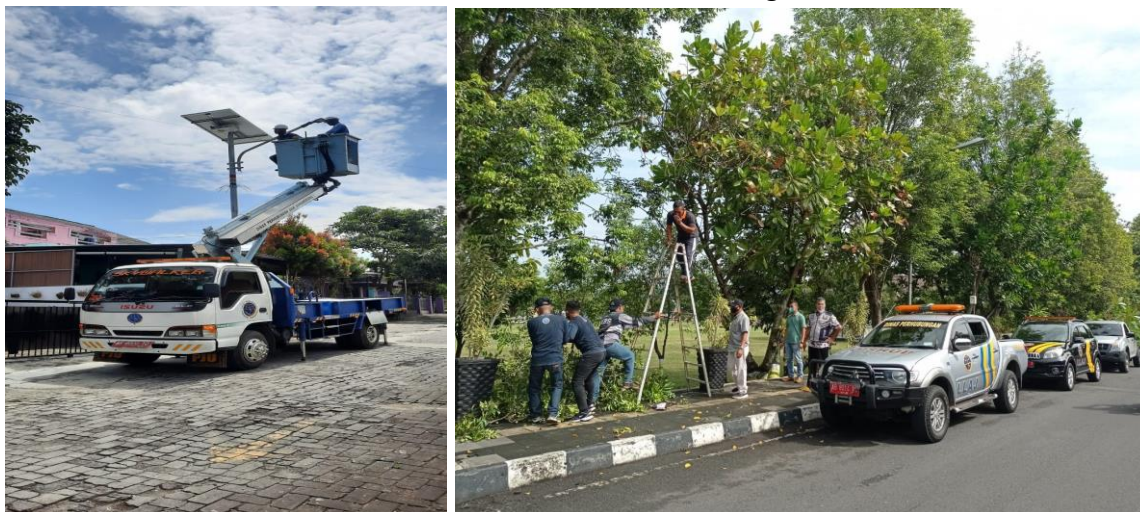
Gambar 3.59 Pemeliharaan lampu penerangan jalan di Jalan Kabupaten maupun di jalan Provinsi bersama Dinas Perhubungan DIY
