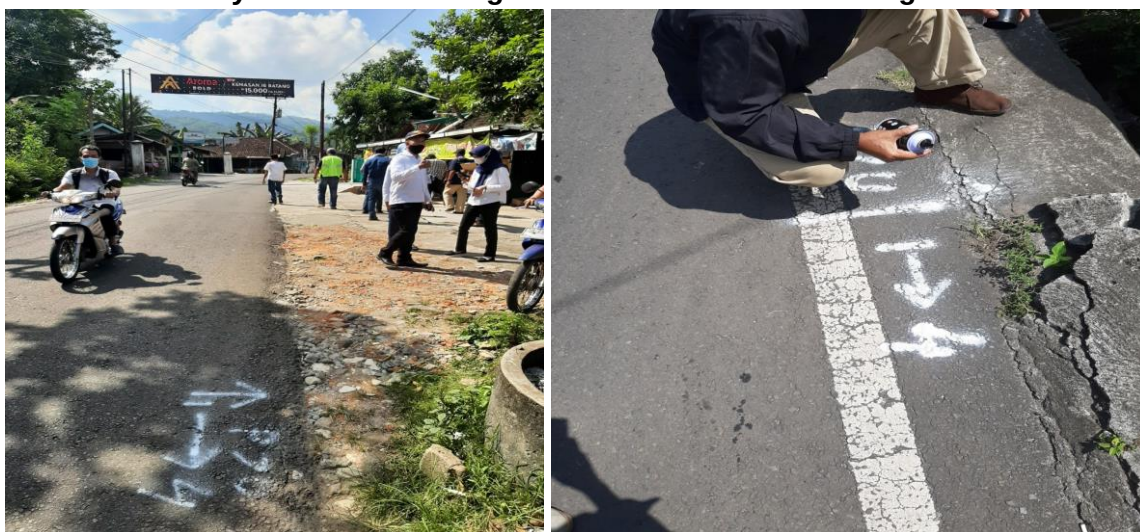
Gambar 3.60 Survey Lokasi Pemasangan PJU dari Dinas Perhubungan DIY
