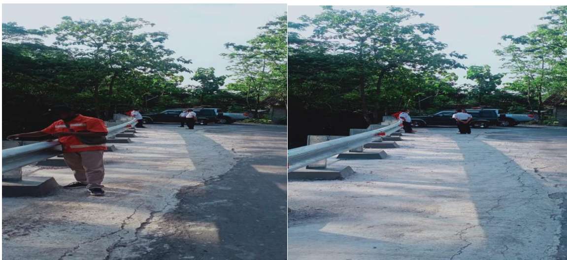
Gambar 3.58 Pengadaan dan pemasangan pagar pengaman jalan (Guardrail)
