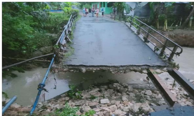
Gambar 3.15 Foto Bencana Jembatan Putus di Padukuhan Pucung
