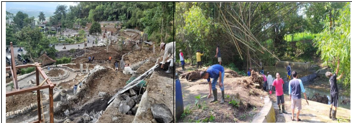
Gambar 3.111 Pembangunan RTH Patuk dan Kegiatan Gerakan Kali Bersih
