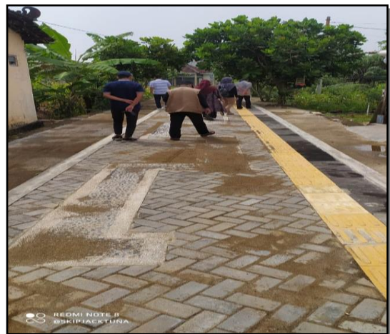
Gambar 3.74 Pembangunan Jalan Pedestrian Pantai Krakal
