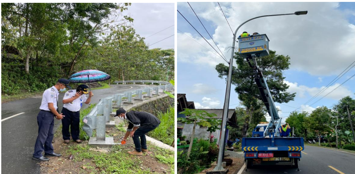
Gambar 3.108 Pembangunan Guardrail dan Pemasangan Lampu Penerangan Jalan Umum
