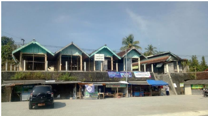
Pemasangan Paving Block Pasar Wotgaleh
