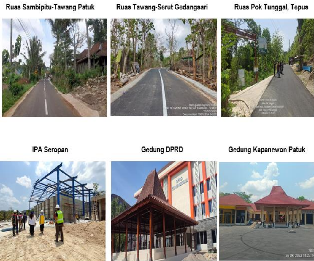
Gambar 3.57 Dokumentasi Hasil Pekerjaan Infrastruktur Pekerjaan Umum
