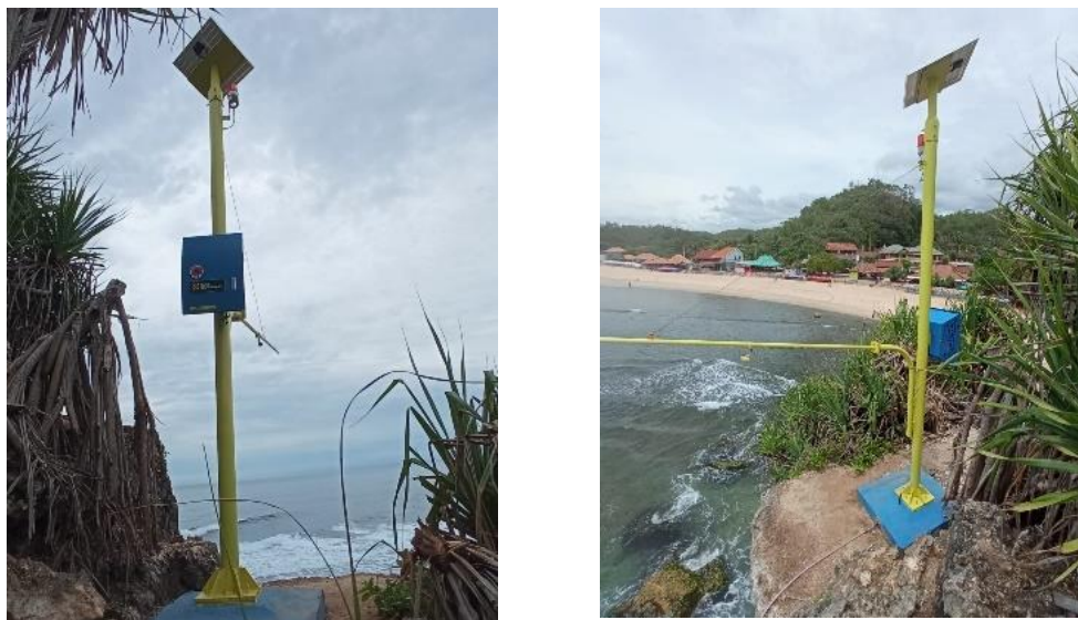
Gambar 3.11. Pemasangan Early Warning System Bencana Tsunami di Kawasan Pantai Selatan
