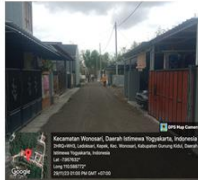
Jalan Lingkungan Perum Adem Ayemi
